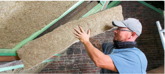
1 Mise en œuvre d'isolation en mode compact sous un rampant sur châssis préfabriqué. Le matelas isolant est maintenu par sa forme et par frottement.
