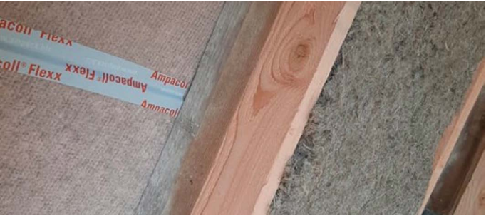
3 Les travaux préparatoires de cette rénovation consistaient à vérifier l'état de la sous-couverture et éventuellement à corriger l'étanchéité au vent. Ici au moyen du Ruban adhésif Ampacoll® Flexx pro , 60 mm et l'apprêt Primer Ampacoll® Airmax .
