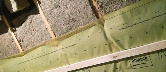
4 Mise en place du pare-vapeur adapté à la construction, Ici Ampatex® DB 90 . Le lattage est monté de façon idoine, le lé ne devant pas supporter le poids de l'isolation.
