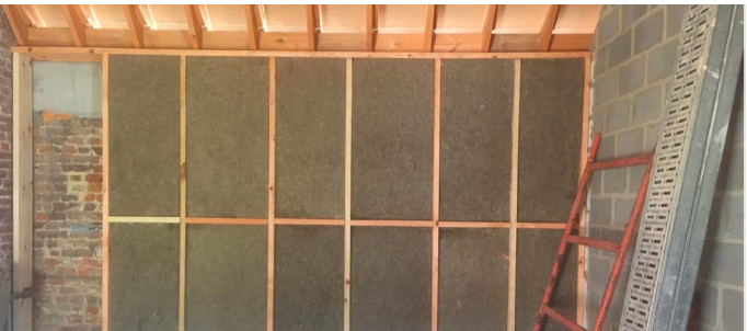
6 Isolation d'un mur en maçonnerie, ici brique en terre cuite. La régulation de la vapeur d'eau se fera au moyen de Ampatex® Cento .
