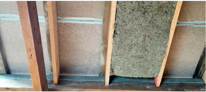
2 Rénovation de toiture, rampant isolé. Le matelas isolant est maintenu par sa forme et par frottement.
